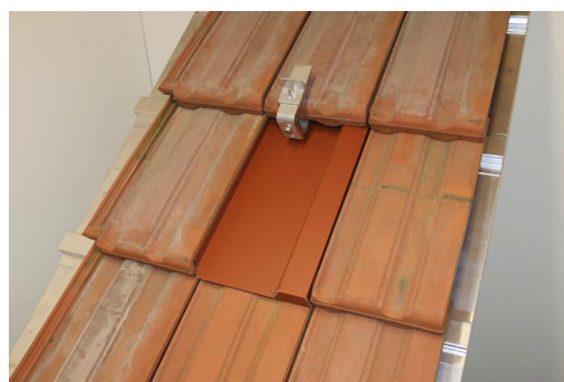
6 Passender Montagehaken befestigen und Tonziegel wieder montieren
