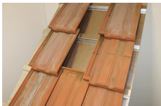
1 Ton/Beton-Ziegel demontieren
