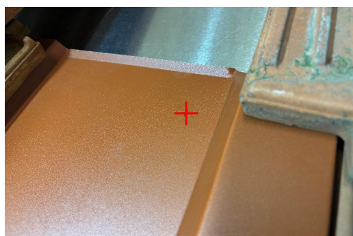
3 Schraube einmessen (rechts) (10mm ab OK Ziegellattung) Vorbohren nicht notwendig
