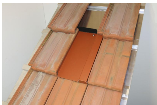
5 Dichtungsband auf Blechziegel kleben (Je nach Temperatur kann es mehrere Stunden dauern, bis das Fugendichtungs- band seine Endstärke von 35mm erreicht)
