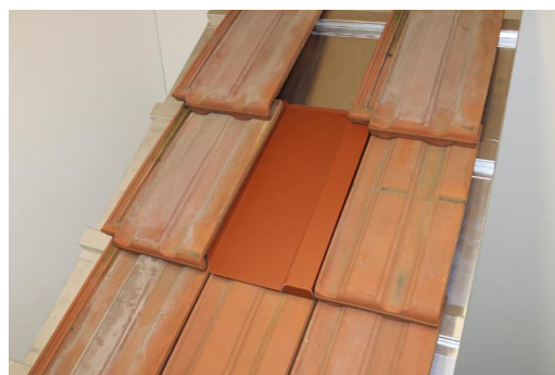
2 Blechziegel einsetzen
